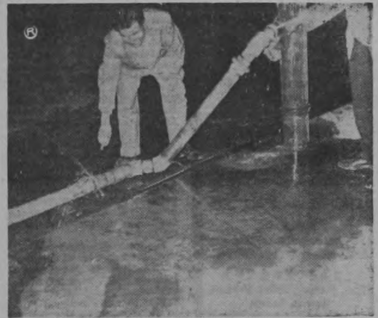
LOS VECINOS SEÑALAN LA TOMA DE AGUA DE UN HIDRANTE, la cual —según aseguran ellos—, fue tan mal hecha, que hasta la ataron con bandas de goma. Esa toma, advirtieron los denunciante estuvo desperdiciando enormes cantidades de agua. Foto MORALES.
