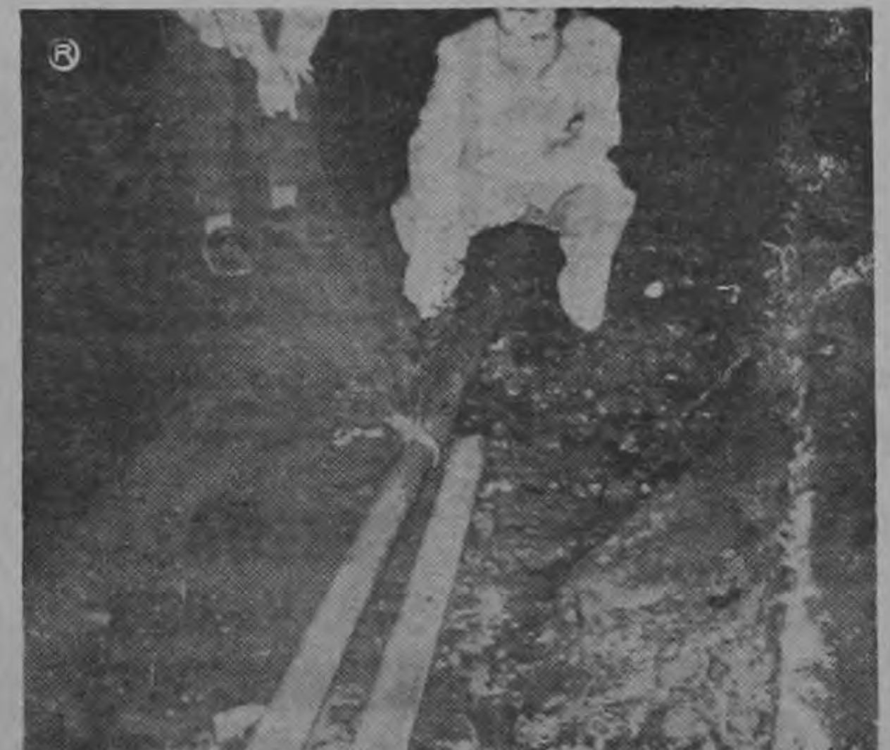
UNA DE LAS FUGAS DE AGUA, que según los vecinos eran sumamente numerosas, eran causadas de acuerdo con los informes que dieron, por malas conexiones. Los vecinos se quejan de que no sólo se les quita el agua sino que la desperdician. En el escrito que enviaron a este periódico indicaron que el mismo SNAA encarece economizar el agua. Foto MORALES.
